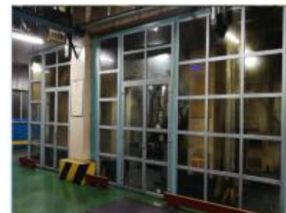
车间产生废气的工段重新制作集烟罩， 重点区域外围增加落地大围挡。
