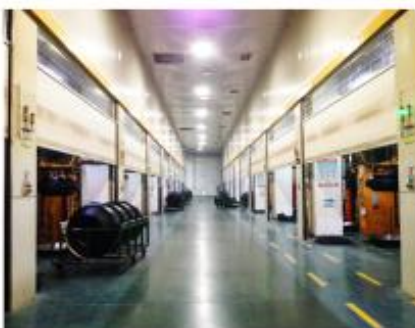
安装卷帘，将产生废气区域进行密闭。
