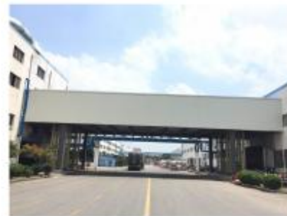
密炼车间与压延车间之间 采用连廊输送胶料，减少废气的散逸。
