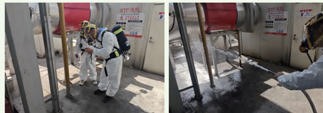
RTO天然气泄漏应急演练
